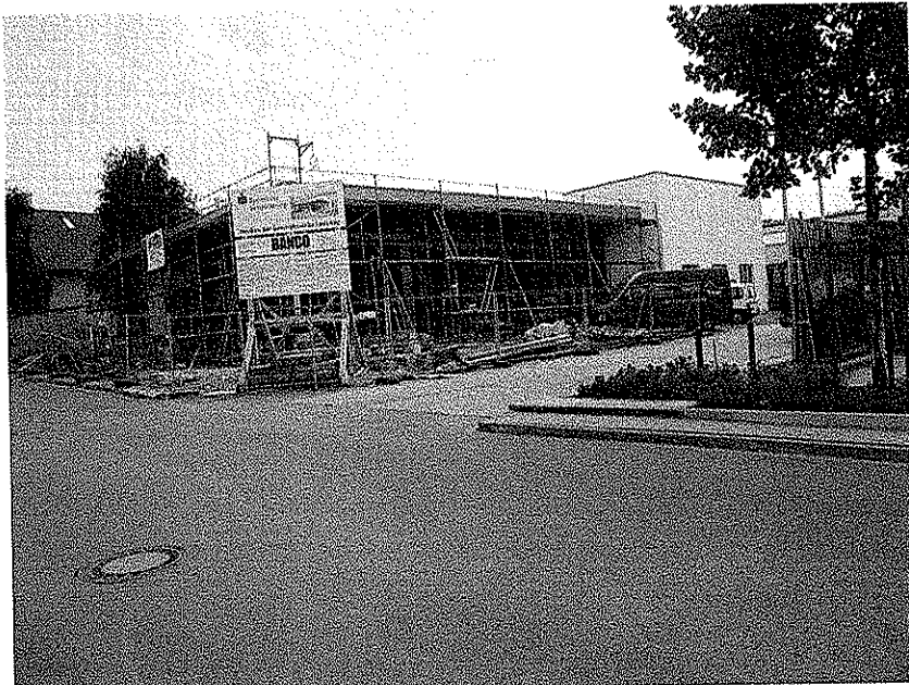
Gewerbepark – Neubau Sparkasse Schaumburg
