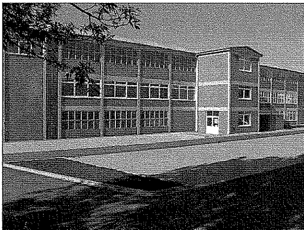
Casala-Gelände Revitalisierte Gewerbezone
