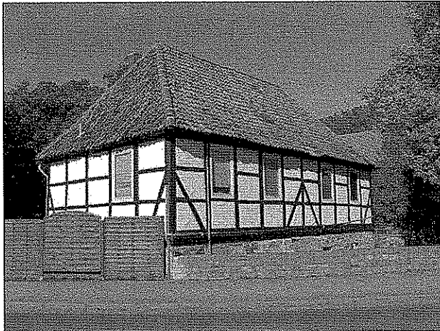
Historische Wohngebäude Am Amtsgraben/Im Mühlenwinkel/Marktstraße
