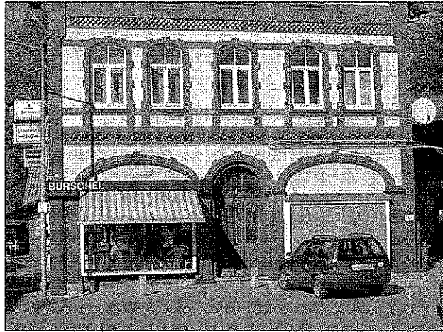
Fassade eines Geschäftshausen - historisch Kleinteiler Aufbau
